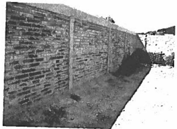
Fotos N°s 61 y 62: Falta de revoque de mortero espesor 20mm
