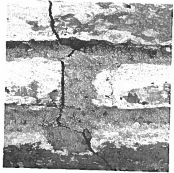
Fotos N°s 59 y 60: Fisuras en muro medianero
