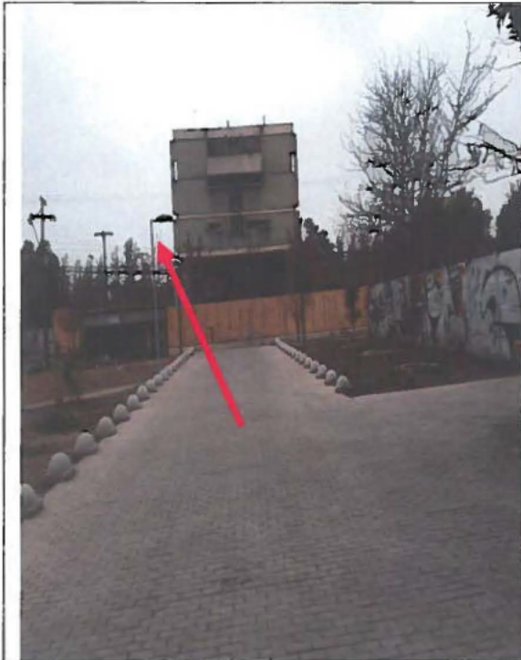
Fotografía N°1: Fecha 20/05/2014. Imagen: Postes de luminarias de 4 metros. Observación: Postes instalados no corresponden a los especificados de 8 metros.
