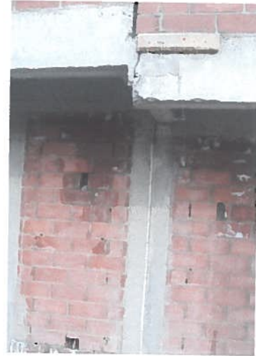
Foto N° 13 Solución de junta con poliestireno expandido en primer piso.
