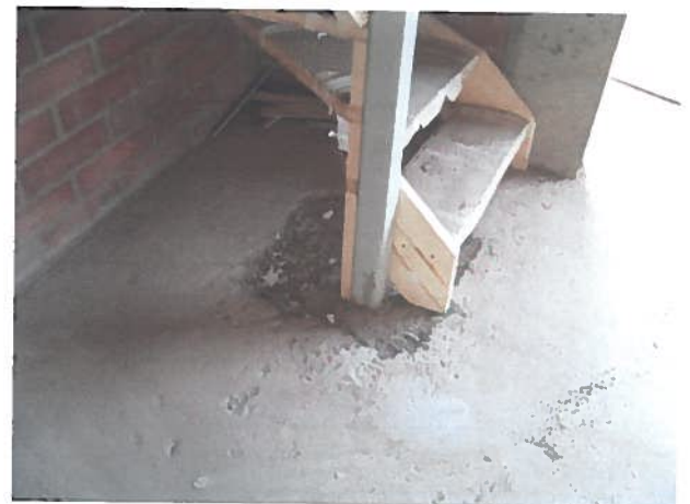
Foto N° 6 Terminación del radier, pilar empotrado y escalera ejecutada.
