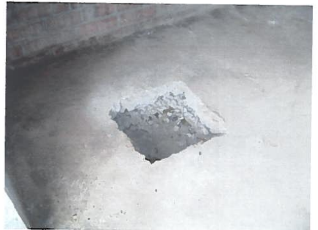
Foto N° 4 Perforación en radier para dar paso al pilar empotrado, sistema constructivo empleado en todas las viviendas.
