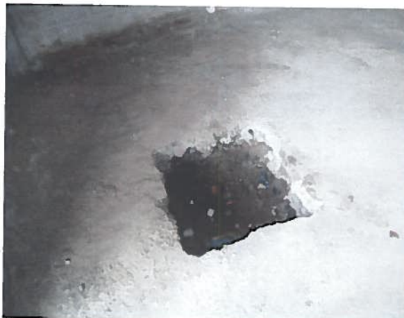
Foto N° 3 Perforación en radier para dar paso al pilar empotrado, sistema constructivo empleado en todas las viviendas.
