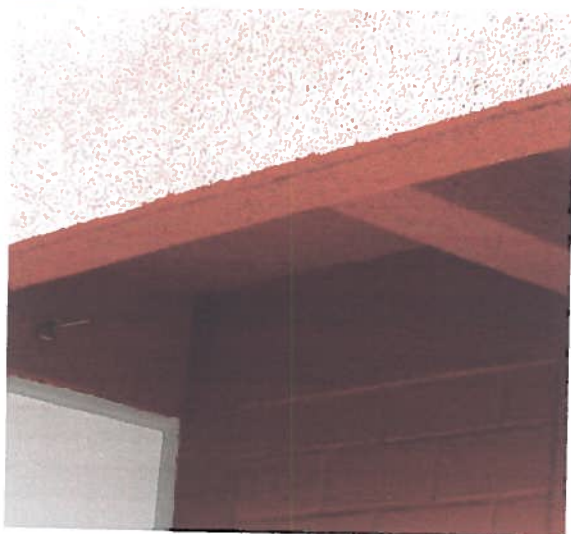
Foto N° 29 Cortagotera luego del tratamiento impermeabilizante.
