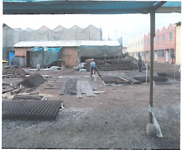
Foto N° 8 Materiales de obra en el exterior.
