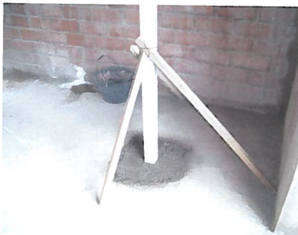
Foto N° 5 Relleno con nuevo hormigón, sistema constructivo empleado en todas las viviendas.
