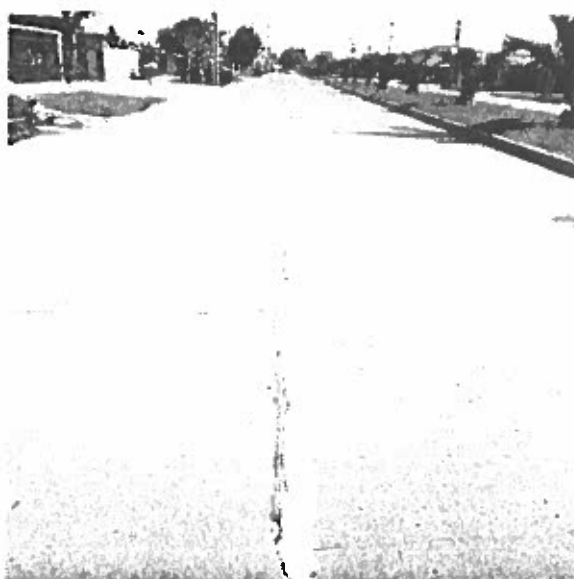
Foto N° 24 – Avenida La Travesía, calzada sur
