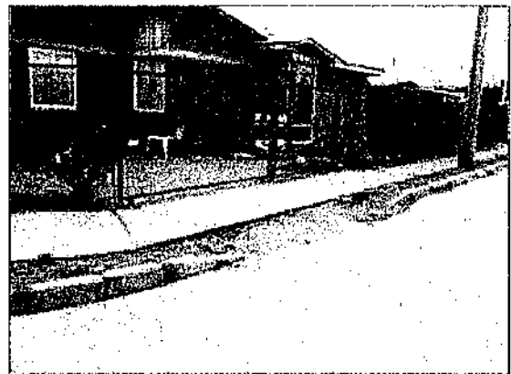
Foto N° 10 Inexistencia de dispositivo de rodados en esquina de calles Los Alerces con Los Olivos
