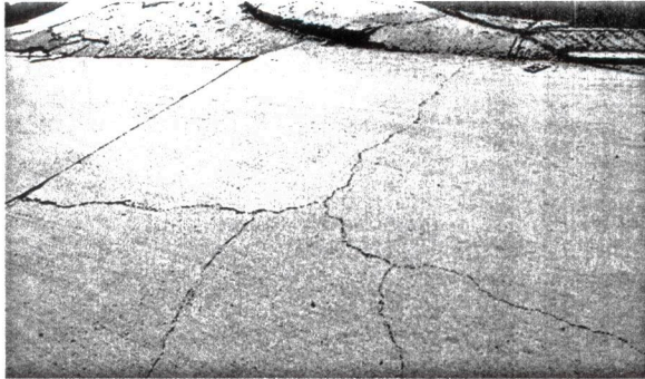
Fotografía N° 7 Lugar: Pje. Achao, entre Av. Talinay y N°716, por el eje de la calzada, La Reina. Observación: Grieta
