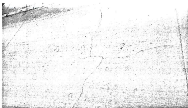
Fotografía N°4 Lugar: Pje. Fray Andrés, entre N°421 y N°423, La Reina. Observación: Fisura
