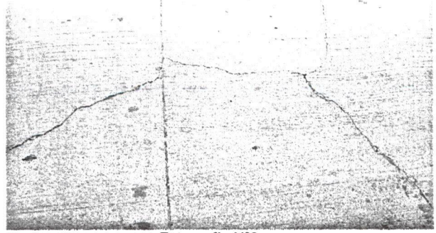
Fotografía N°8 Lugar: Pje. Achao, frente N°723, La Reina. Observación: Fisuras
