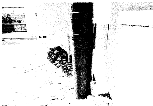
Foto N° 66: Taco de madera sin impregnación
