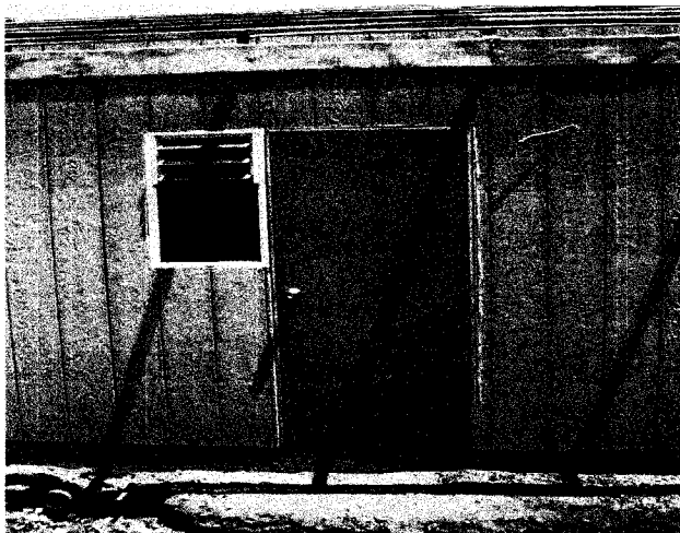
Foto N° 31: Falta de celosía en puerta cocina y baño
