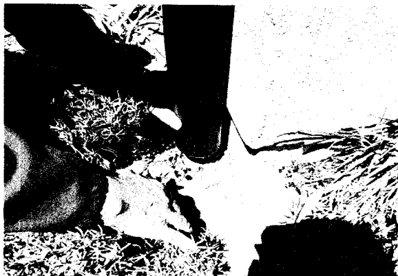
Foto N° 65: Falta de codo en bajada de agua lluvia
