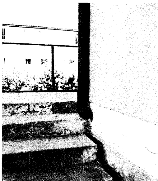
Foto N° 65: Falta de codo en bajada de agua lluvia
