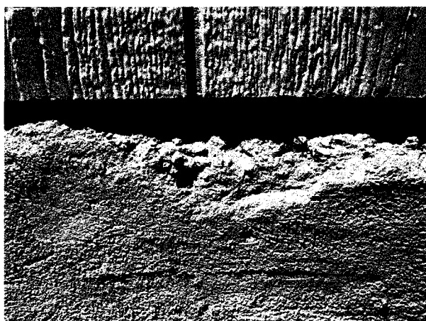
Fotos N°s 33 y 34: Nidos de piedras y fisuras en sobrecimiento
