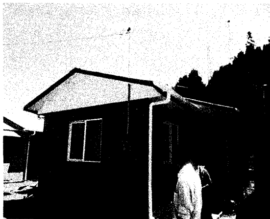
FOTO 13 FALTA VENTILACION FRONTONES
