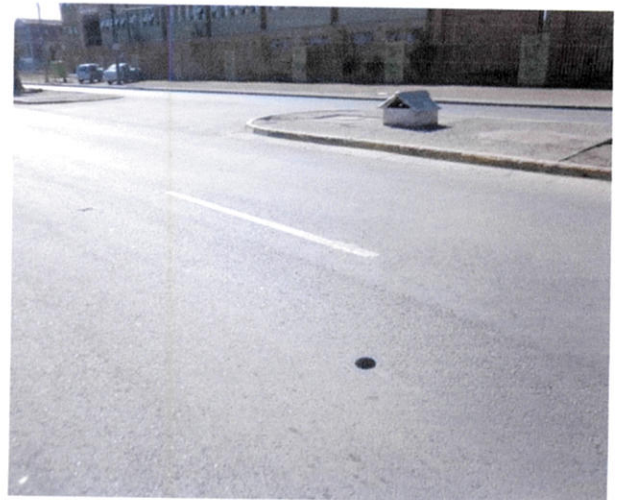
Foto N° 6 – Avenida La Estrella, calzada poniente
