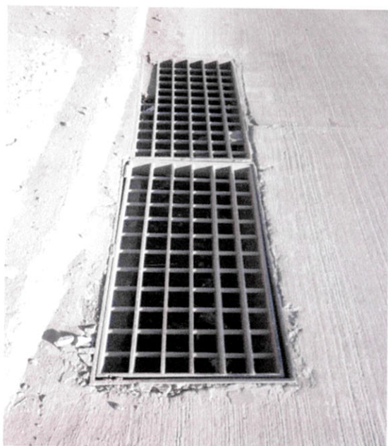
Foto N° 31 – Avenida Federico Errázuriz
