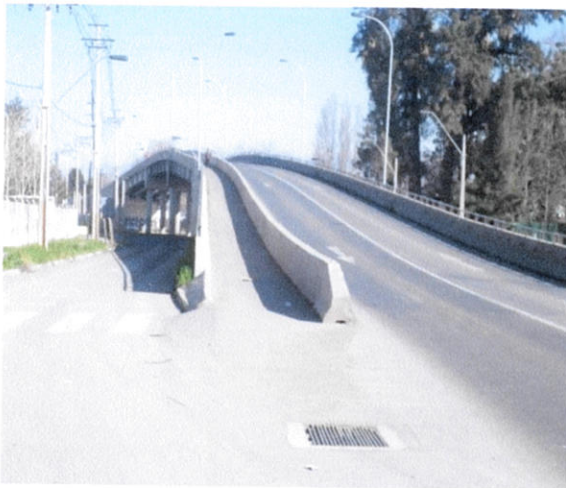
Foto N o 53 – Paso superior avenida Matta, extremo oriente, costado sur
