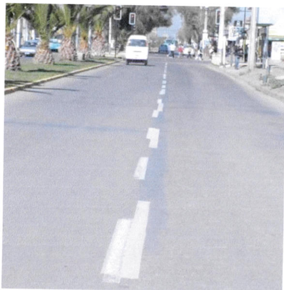
Foto N° 23 – Avenida La Estrella, calzada oriente
