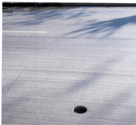
Foto N° 8 – Avenida Federico Errázuriz, calzada oriente
