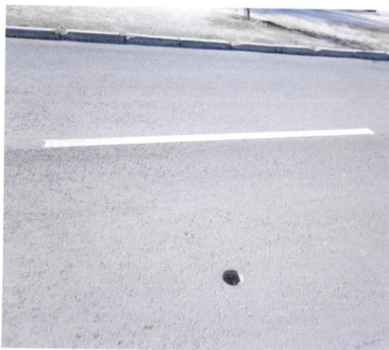
Foto N° 5 – Avenida Las Torres, calzada poniente
