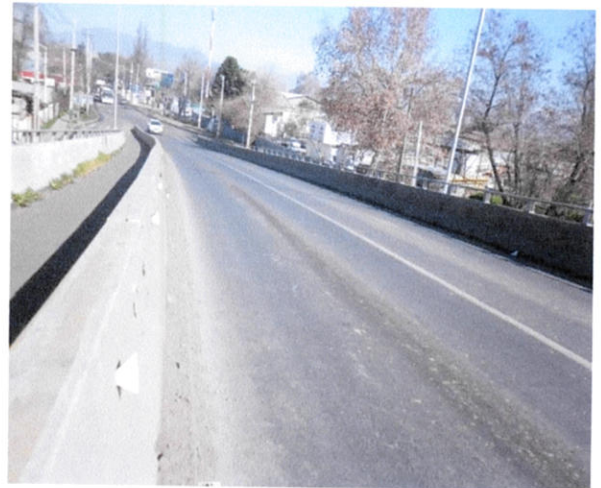
Foto N o 54 – Paso superior avenida Matta, extremo poniente
