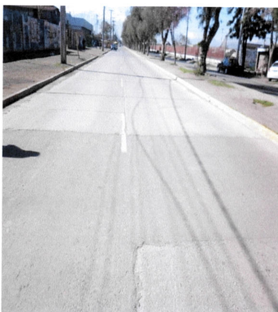
Foto N° 33 – Avenida La Travesía, calzada norte
